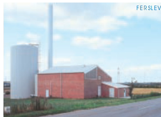
Skorsten og varmtvandstanken er placeret med omtanke og farverne matcher farverne på tag, døre og vinduer.
