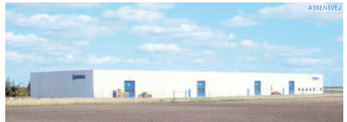
Produktionsbygningen i dens rene form med god balance i facadeudtrykket og med administrationen integreret i bygningen.
