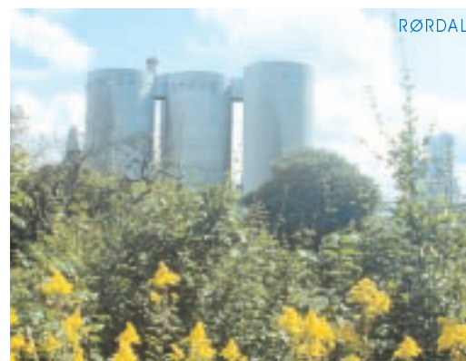
Tekniske installationer kan have skulpturel virkning. De rene former og de lyse betonfarver dominerer ikke på samme måde som kunstfærdige udformninger og stærke farver.
