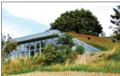
Eksempel på et bygningsanlæg, der er flot indpasset og integreret i landskabet.
