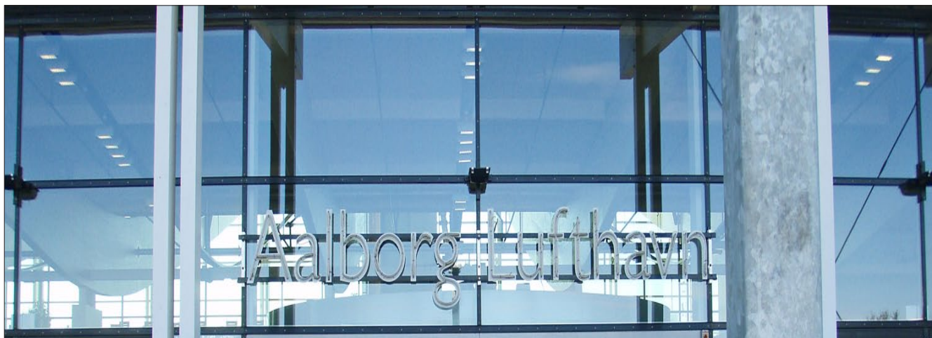
Til højre ses terminalen, som kan udvides i begge ender. Til venstre, ved den grå bygning, opføres hotel.
