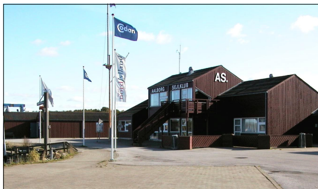
Bygningerne der huser Aalborg Sejlklub ved marinaen.
