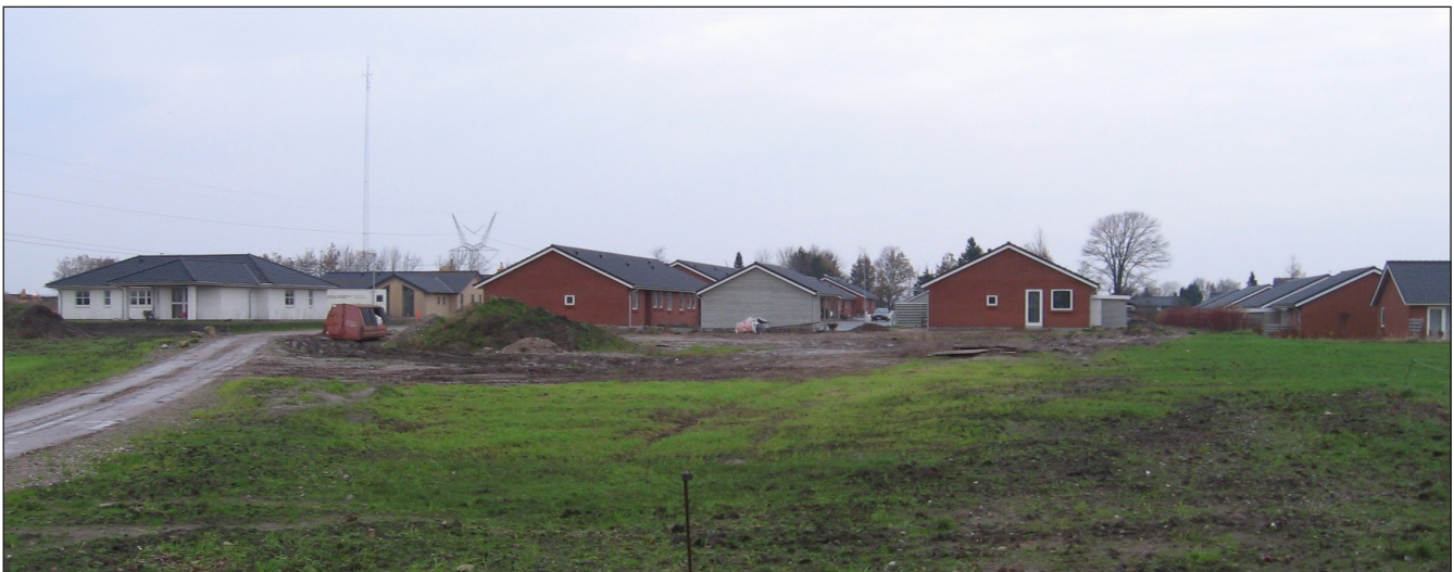
Billedet viser boligerne på den del af Kærhavegårdvej, der er udbygget. Vejbetjeningen af lokalplanområdet sker ved at forlænge Kærhavegårdvej, ca. der hvor den røde container på billedet står.
