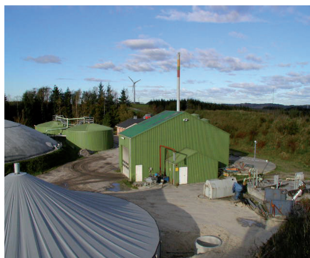
Biogasanlæggets aflæssehal th i billedet og ny fortank tv.
