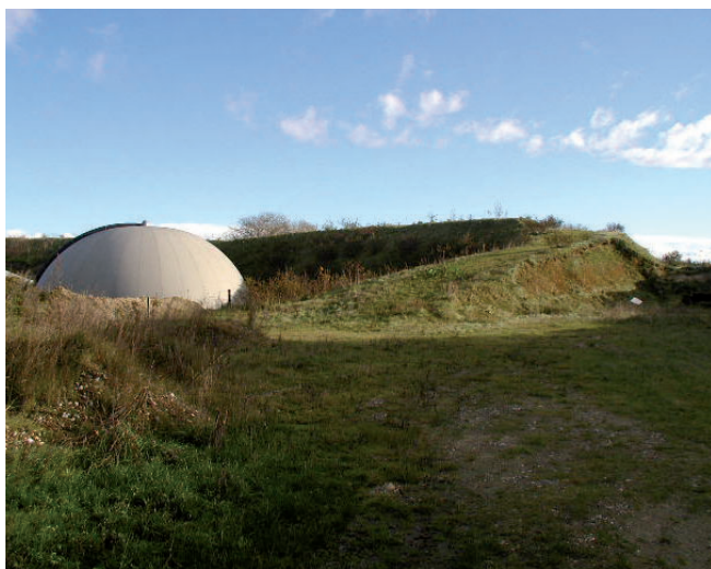
Biogasanlæggets sydlige tank, der ligger delvist skjult bag en skråning
