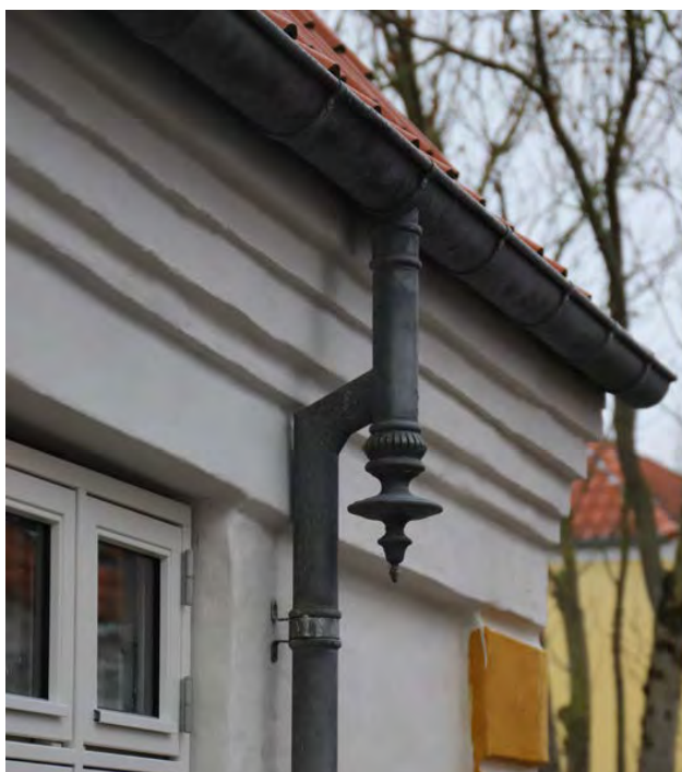
Muret hovedgesims og et smukt detaljeret nedløbsrør.
