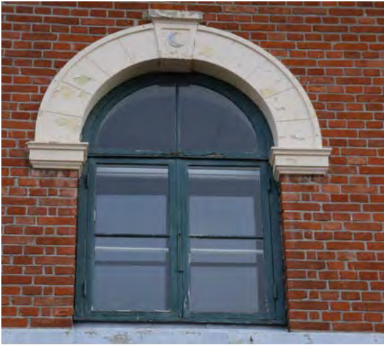
Dannebrogsvindue med buet overkant og tynd vandret sprøse i nederste ramme.
