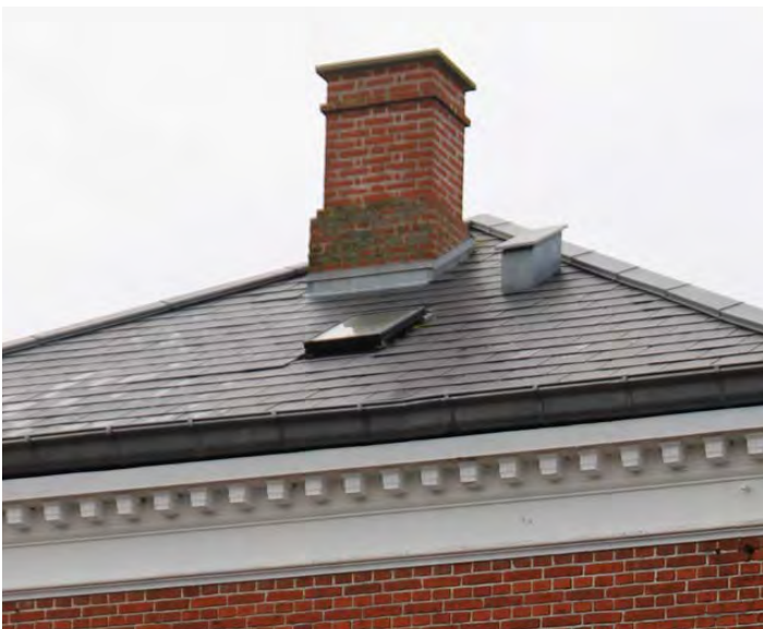
Skifertag var et nye tagmateriale . Skifer og tegltag er de to anvendte tagmaterialer på periodens bygninger.
