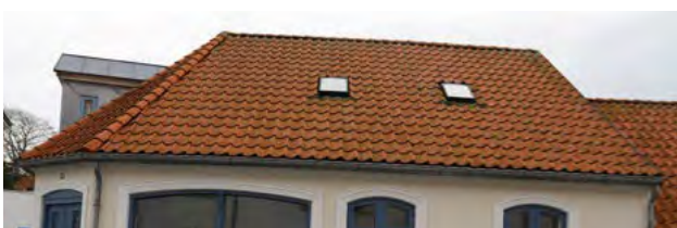
Røde vingetegl er det helt gennemgående tagmateriale for denne bygningstype.
