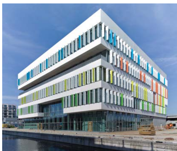
Gymnasium, Ørestaden, 3XN
