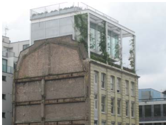
Ombygget tagterrasse, London, Arkitekt ukendt
