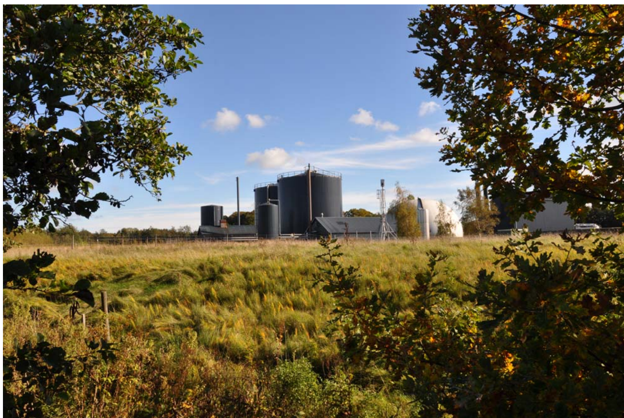
Thorsø Biogas. Foto: Biogassekretariatet.
