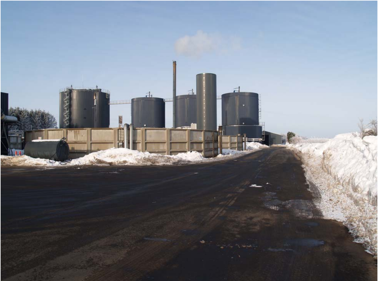
Lemvig Biogas. I forgrunden ses 2 efterlagertanke og i baggrunden ses 4 rådnetanke. Foto: Biogassekretariatet.
