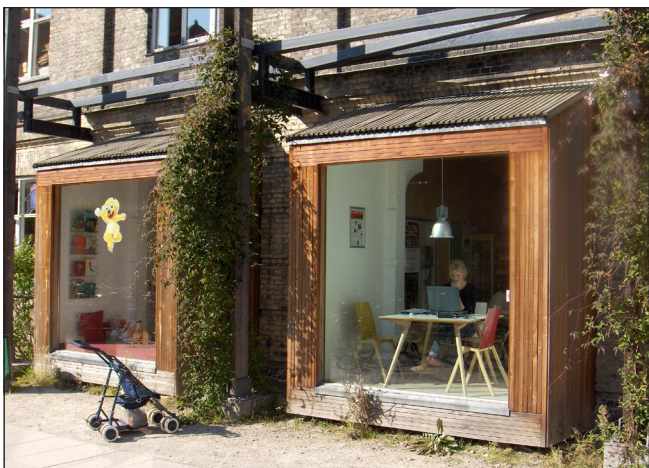
Eksempel på en åben facade - man kan ikke gå ind, men man kan se liv bag facaden (Holmbladsgade, København).
