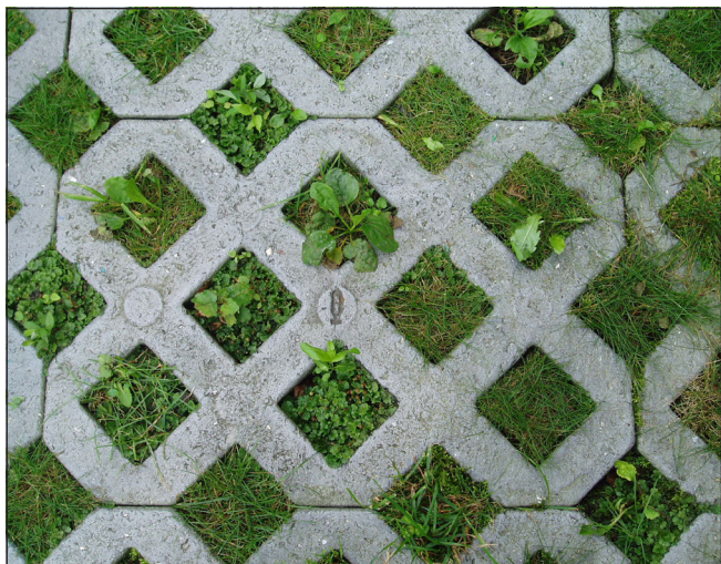
Permeabel befæstelse: Schwarsach Østrig - genbrugsplast rist med græs på P-areal. Foto: Rie Øhlenschläger/AplusB.
