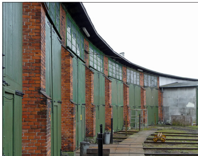
Remisebygningen er et vigtigt spor fra en svunden tid.
