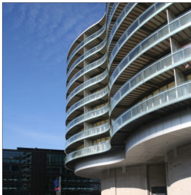
Frøilos, Islands Brygge. Arkitekt: MVRDV, Holland, 2005.
