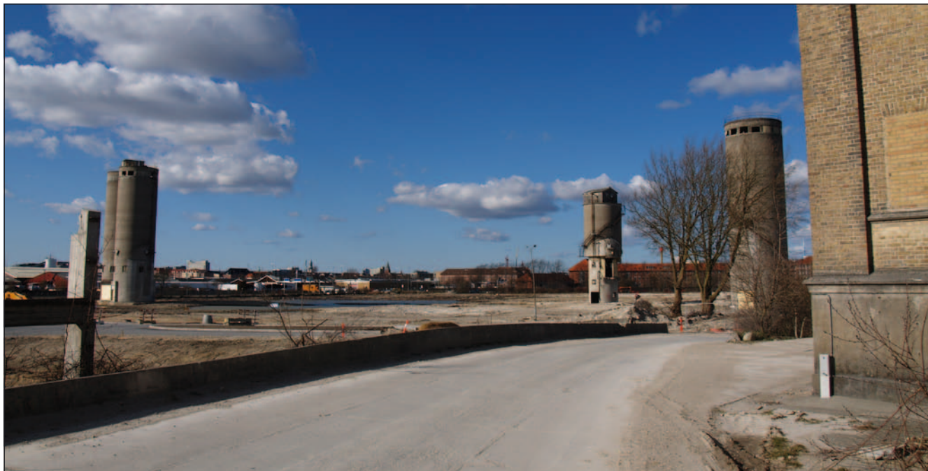
Vue over hjørnegrunden (delområde A) i nordlig retning set fra den gamle kraftcentral. Området er stort set rømmet for det tidligere fabriksanlæg - kun enkelte siloer og portnerboligen står tilbage.
