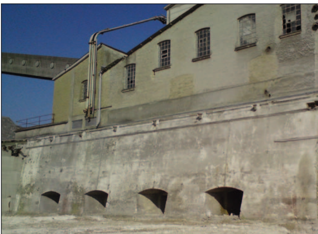
Det tidligere skaktovnsanlæg fremstår idag som en del af en "bastion", der ønskes bevaret som et karakteristisk kulturspor langs bygaden.
