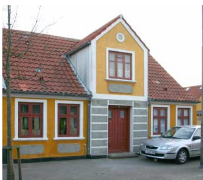
Enkeltfags gavlkvist i Store Tranegade.
