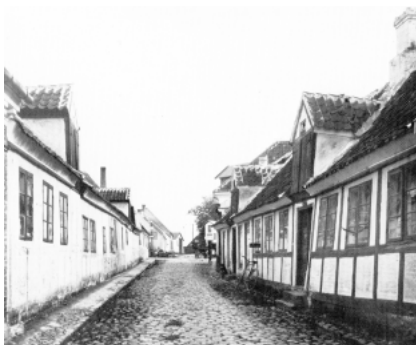
De ældste enkeltfags kviste over indgangsdøren i Nibes bindingsværkshuse. Her Grydstedgade.
