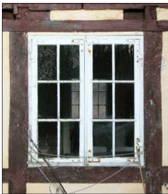
Det ældste vindue fra bindingsværkshusenes tid.
