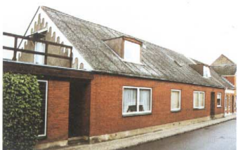
Søndergade 22a Arkitektonisk værdi / 8 Kulturhistorisk værdi / 6 Miljømæssig værdi / 6 Originalitet / 8 Tilstand / 5 Bevaringsværdi / 8
