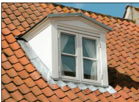
Moderne udgave af enkeltfags tagkvist. Bemærk det forholdsvis flade og meget diskrete tag med zinkafdækning og gesimsafslutning langs spejl og flunker.
