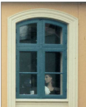
De første dannebrogsvinduer med sprossen i underrammen
