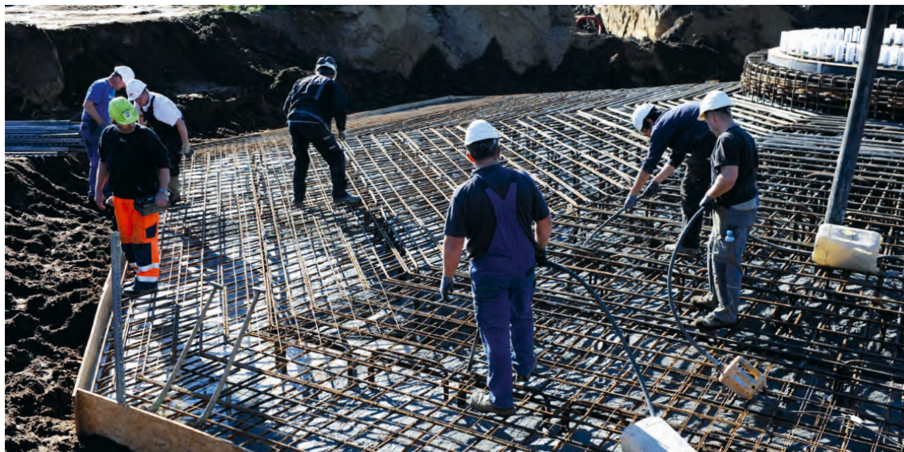
Foto 3.5 Støbning af pladefundament
