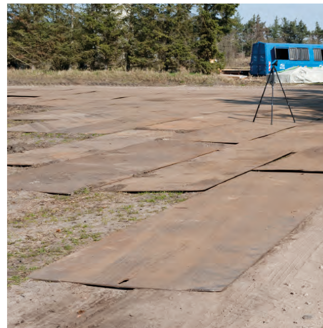
Foto 3.3 Sving på arbejdsvej af jernplader.
