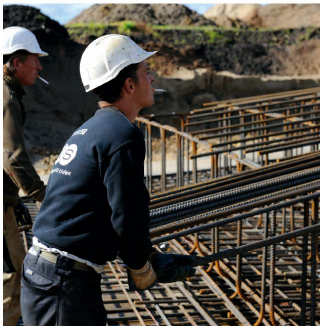
Foto 3.4 Oplægning af armering til pladefundament
