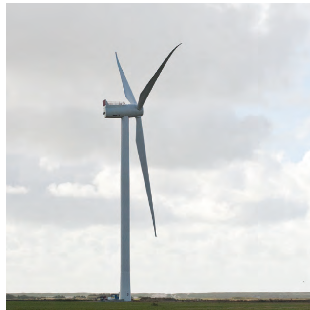
Foto 3.1 Møllehus på en gearløs Siemens vindmølle med 113 meter rotor. Tårnet er placeret midt på møllehuset.
