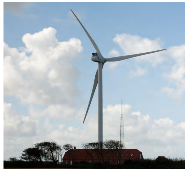
Foto 3.2. Møllehus på en Vestas med 112 meter rotor og gear. Tårnet er traditionelt placeret forrest på møllehatten. Foto fra Prøvestationen ved Høvsøre.
