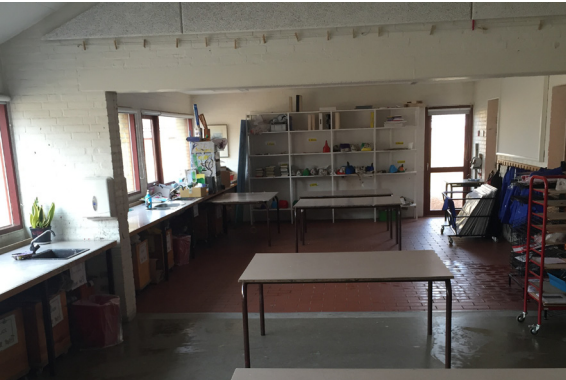
Det eksisterende billedkunstlokale er nedslidt og trænger til en renovering.
