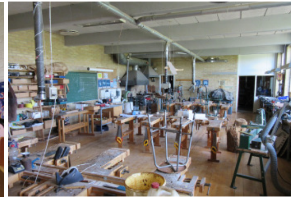
Det gamle sløjdlokale er utidssvarende og nedslidt. Området kan indrettes til det nye fag Håndværk & design ved en sammenlægning med det tilstødende billedkunst lokale.
