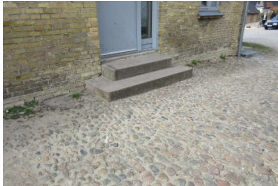
Indgangene i stuehuset er ikke niveaufri. Der skal etableres ramper.
